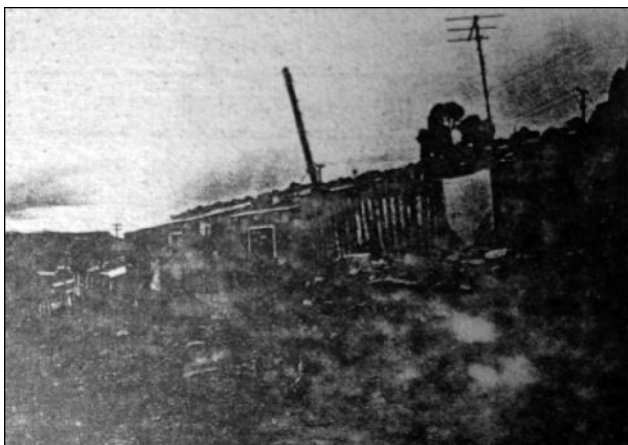
LAS INSALUBRES VIVIENDAS MINERAS
