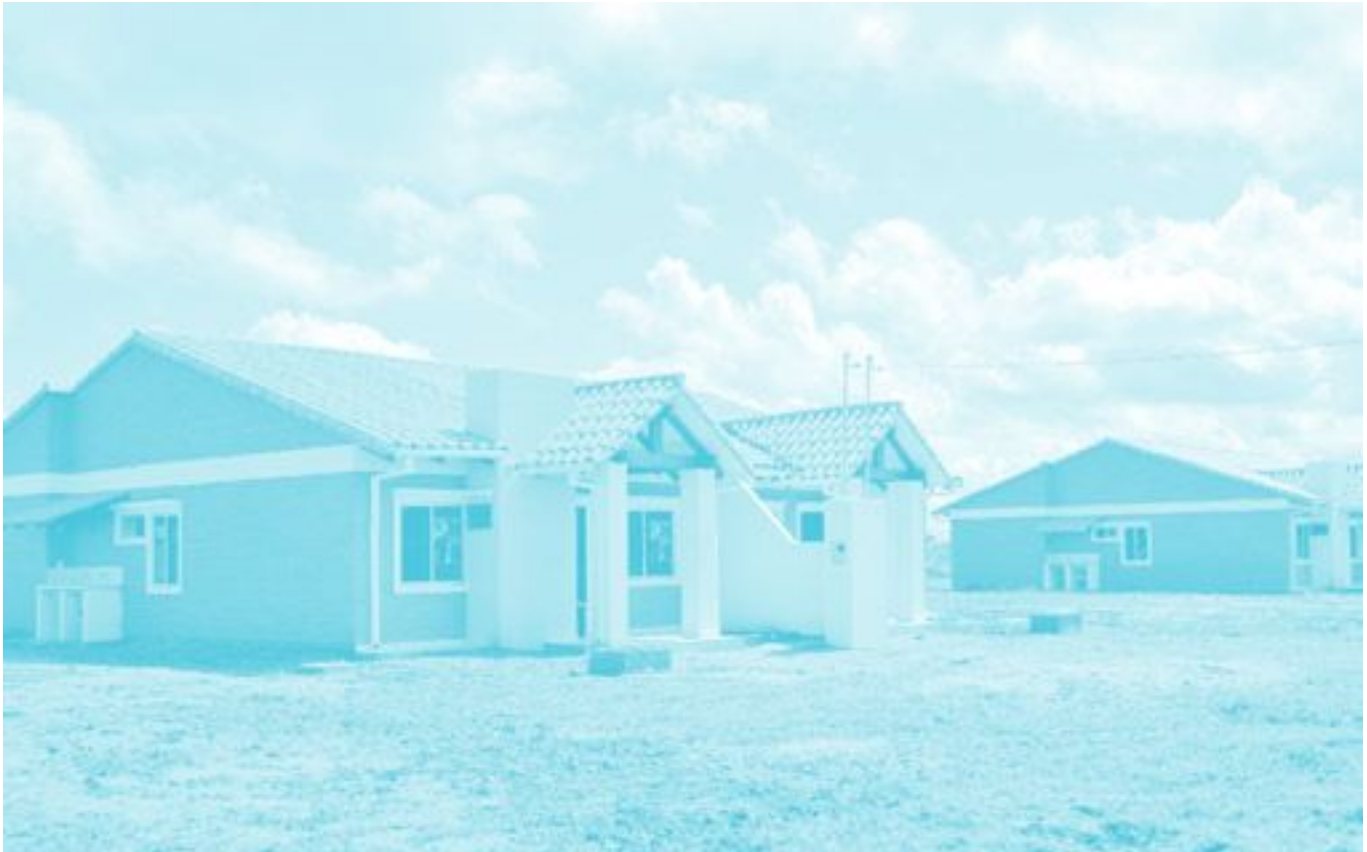
Viviendas entregadas por el Gobierno en el departamento de Santa Cruz en febrero de 2013
